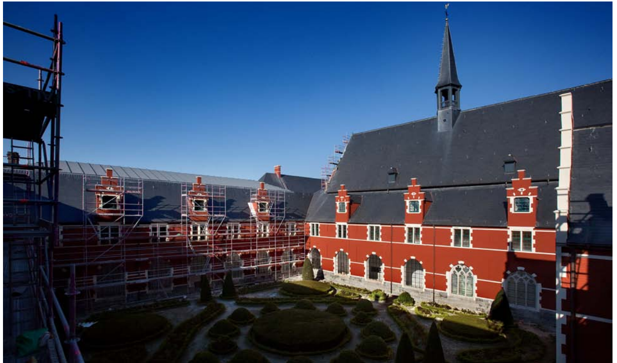
Façades XIV e restaurées de l'abbaye de la Bijloke, avril 2010 © Phile Deprez
