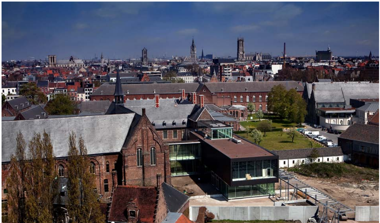
Photo du chantier du STAM, avril 2010 © Phile Deprez
