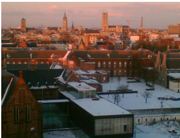
Photo du chantier, hiver 2010 © Bart Rondas
